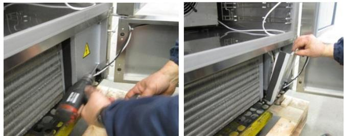
Verriegelungsschrauben des Schaltkastens entfernen.
