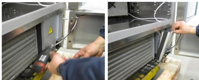
Удалить фиксирующие винты электрического щита.
