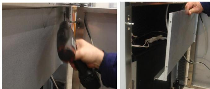
Удалить фиксирующие винты электрического щита.
